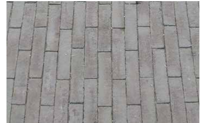
Materialisering speelstoep: betonstraatsteen waalformaat, lichte kleur met glimmer
