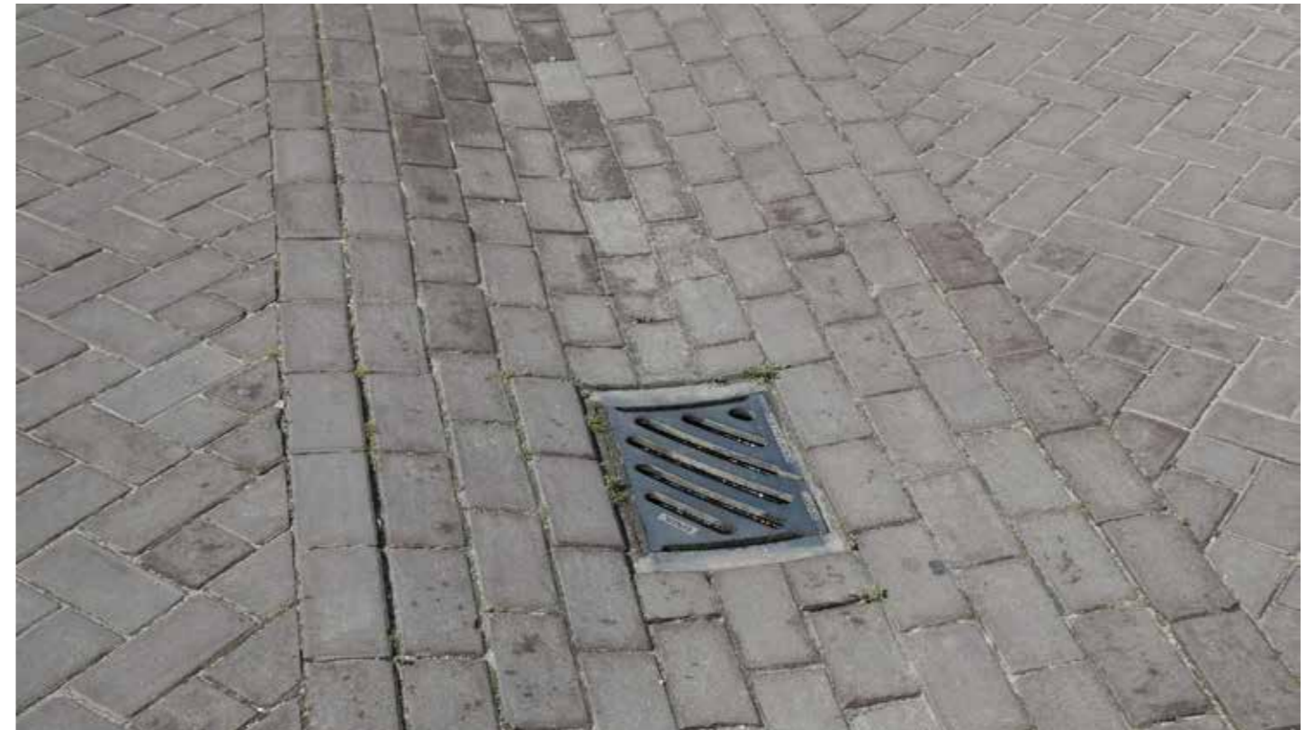
Afwatering via brede goot van 9 strekken dikformaat naar diepe wadi Beplantingsvakken liggen hoger en krijgen geen water van de weg
