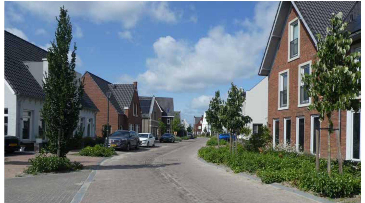
Afwatering via brede goot van 9 strekken dikformaat naar diepe wadi Beplantingsvakken liggen hoger en krijgen geen water van de weg
